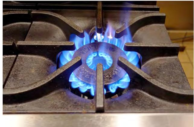
**Advertencia de seguridad:** Asegúrese de que los encendidos de todos los pilotos funcionan y están bien ajustados. Los encendidos que faltan o no funcionan pueden crear una situación peligrosa en la que el gas natural quede saliendo del cabezal del quemador sin que se encienda.
